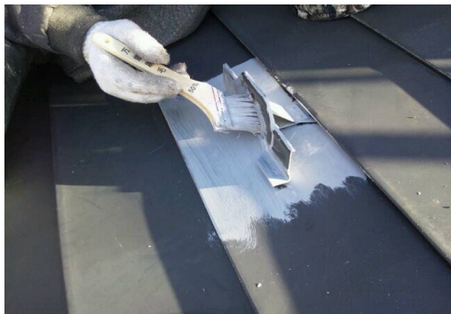
雪止：強化錆止めエポキシ塗装
