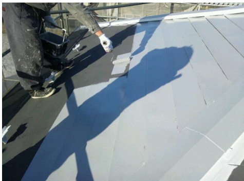
屋根強化錆止めエポキシ塗装
