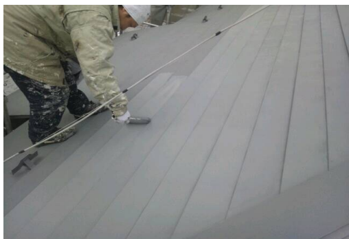
屋根：ガイナ上塗り施工
